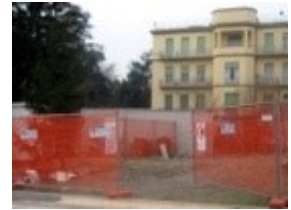
ALLESTIMENTO CANTIERE STRADALE
